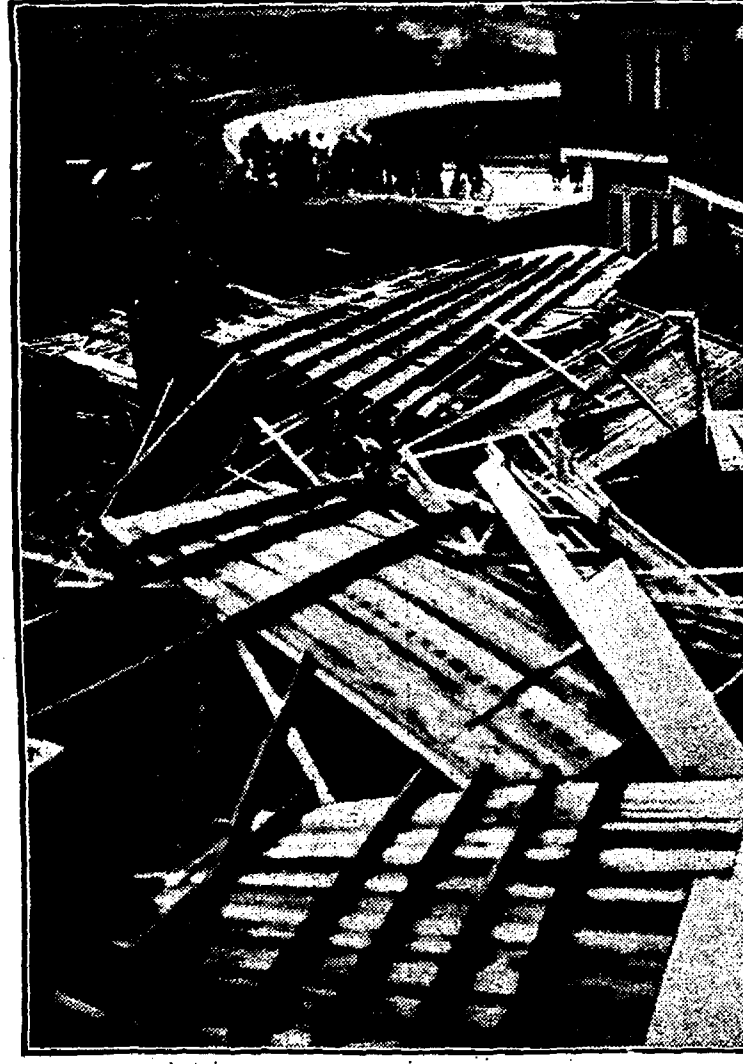
In de Harderwijkstraat (Zuiderparkbuurt) is het dak van een blok huizen door den storm in de tuinen gellingend.
